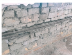
vizesedés miatti levert vakolatrétegek
