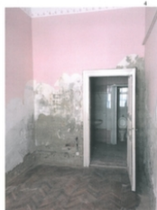
vizesedés miatti levert vakolatrétegek
